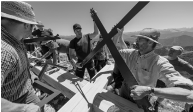
Nach dem Zusammensetzen des Kreuzes werden die insgesamt 200 Kilogramm schweren Beschläge montiert.
